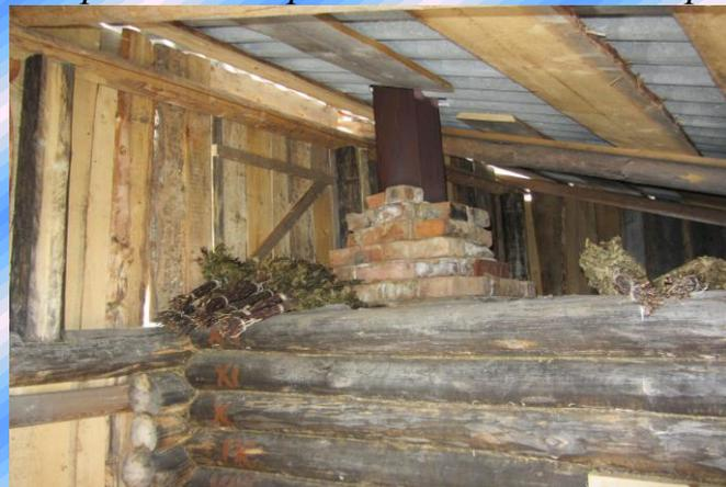
*-разделка дымовой трубы в месте примыкания к горючим конструкциям должна быть не менее 0,5 метров, а отступ от кирпичной печи до деревянных конструкций не менее 0,32 метра;*
